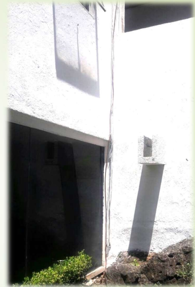
Conexión con grapas de sujeción de sus extremos a la antena y el otro con una varilla de cobre de 2 mts.
